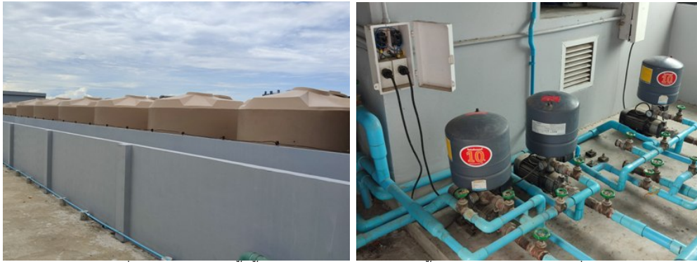
ภาพที่ 10-23 ถังสำรองน้ำชั้นดาดฟ้า และระบบท่อจ่ายน้ำประปาอยู่ในสภาพดีไม่รั่วซึม
