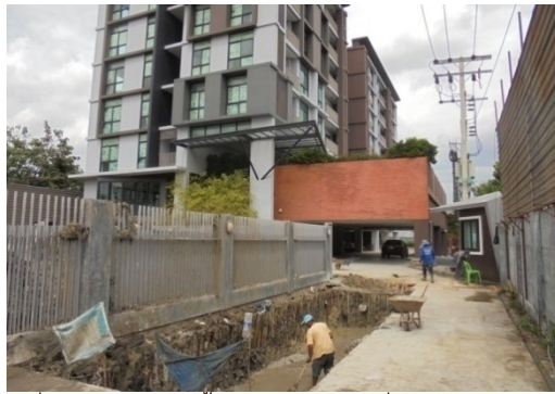
ภาพที่ 10-15 บ่อหน่วงน้ำอยู่บริเวณใต้ทางวิ่งรถเข้าออกโครงการ
